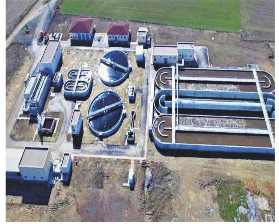
Akşehir Wastewater Treatment Plant – Construction Year:2016 – Capacity: 15.000 m3/day Akşehir Atıksu Arıtma Tesisi – Yapım Yılı:2016 – Kapasite: 15.000 m3/gün
