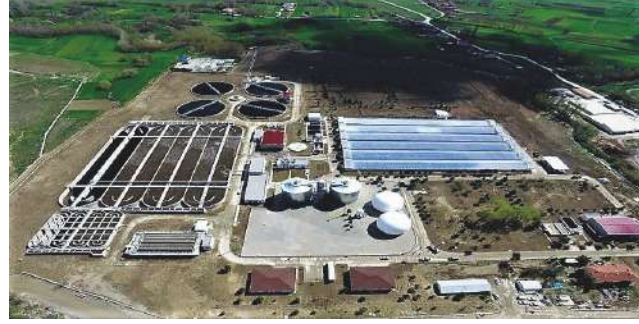
Çiğli Sludge Digestion ve Sludge Drying Plant –Construction Year:2014 – Capacity: 2.500 m3/day (Sludge Digestion)- 800 ton/day (Sludge Drying) Kütahya Atıksu Arıtma Tesisi – Yapım Yılı:2016 – Kapasite: 98.000 m3/gün – 6 solar kurutma holü
