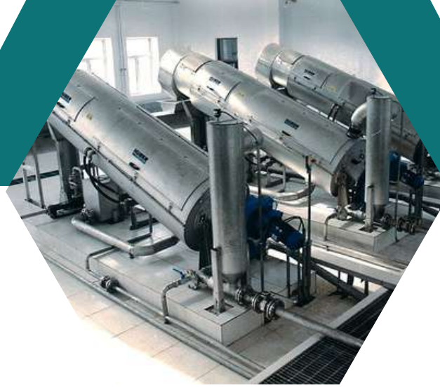
Çamur Susuzlaştırma Binası
